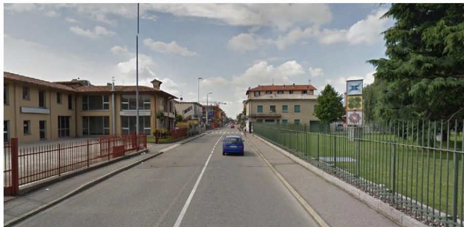
Foto 6 – S6: via per Zanica nord – direzione sud
