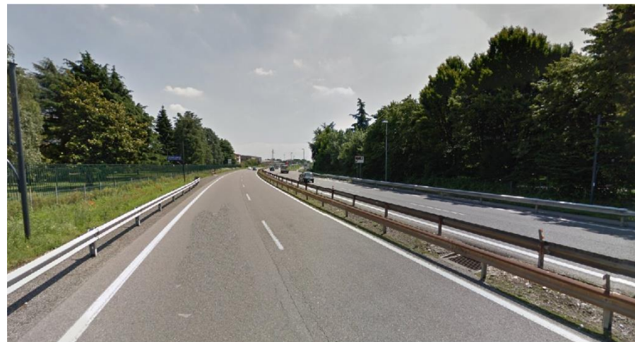
Foto 1 – S1: via Autostrada nord – direzione sud
