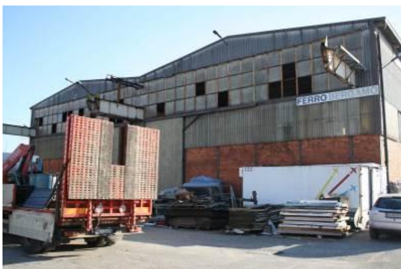
Fig. 2 Magazzino materiali edili
